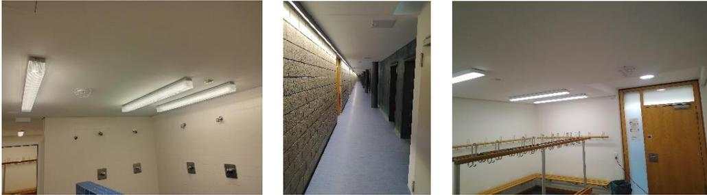
Die 4-Feld-Sporthalle konnte mit ballwurfsicheren LED Tiefstrahlern in der vorhandenen Deckenkonstruktion ausgerüstet werden, welche durch die ihre lange Lebensdauer instandhaltungsfreudig sind.
