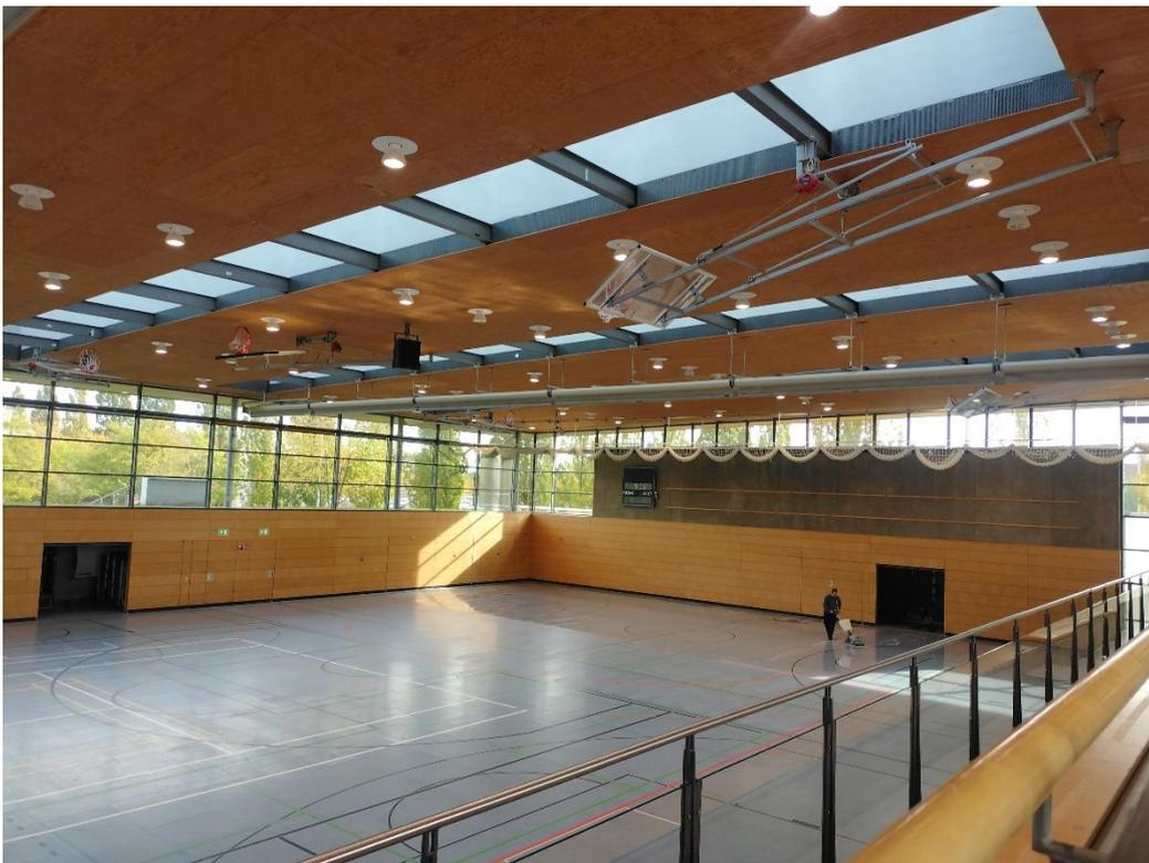
Die Steuerung der Beleuchtungsanlage der Feldbeleuchtung ist DALI-basierend aufgebaut, sodass in Abhängigkeit des Tageslichteinfalles der Lichtstrom reduziert werden kann. Sämtliche Schaltungen und Szenarien aus Nutzung und Betreuung sind mit KNX aufgebaut und auf ein Tableau im Raum des Sportwartes zusammengeführt.
